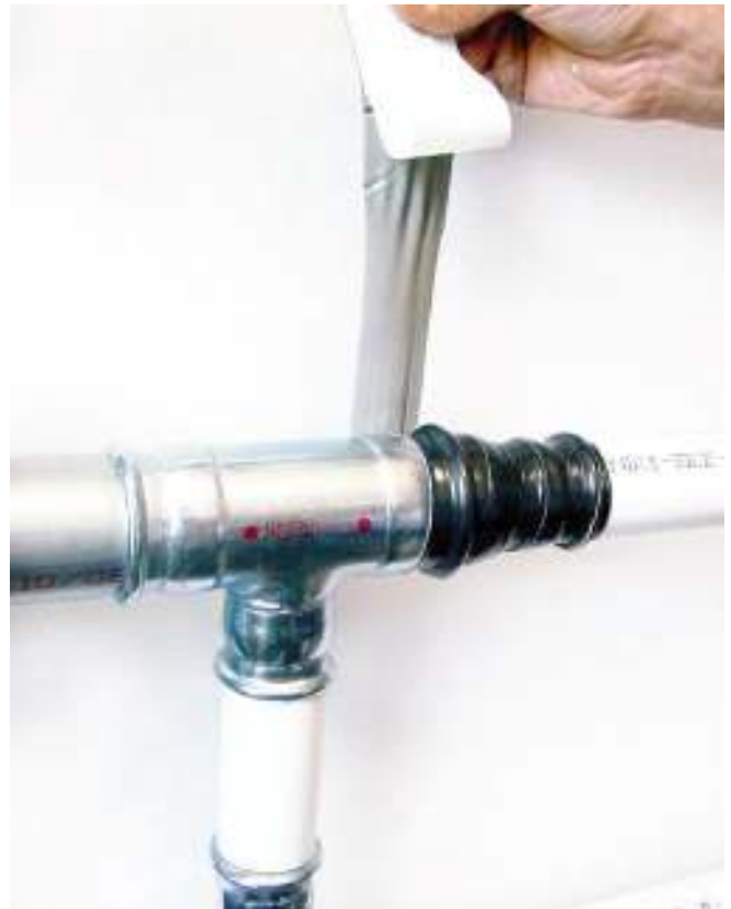
Рис. 38. Защита соединений с помощью бутаноловой клейкой ленты.
